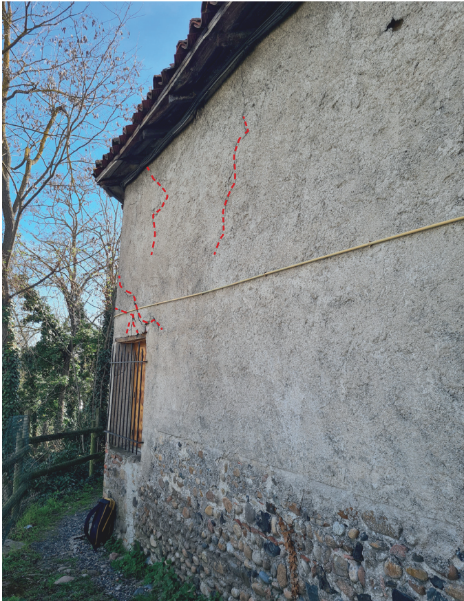
Fig. 39 | Fissures en partie haute de l'élévation nord des communs. Décollement de l'enduit et léger affaissement du linteau bois.
