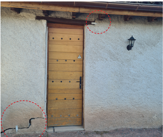
Fig. 32 | Fractures au niveau de l'extension avec jauges graduées (Saugniac) pour surveillance.
