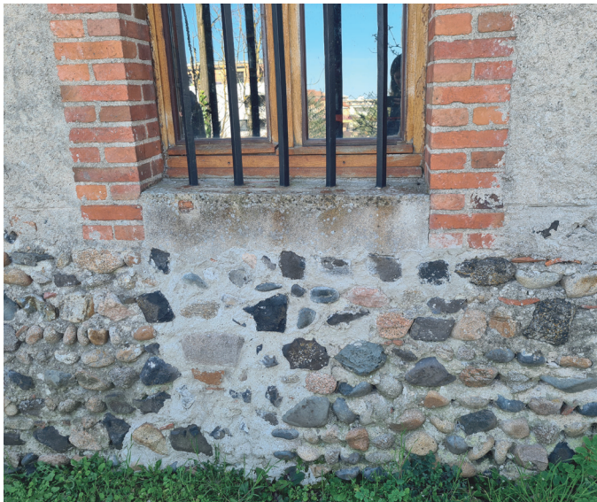
Fig. 38 | Exemple d'une reprise de l'allège sur l'élévation nord des communs. Reprise non ré-ouverte.
