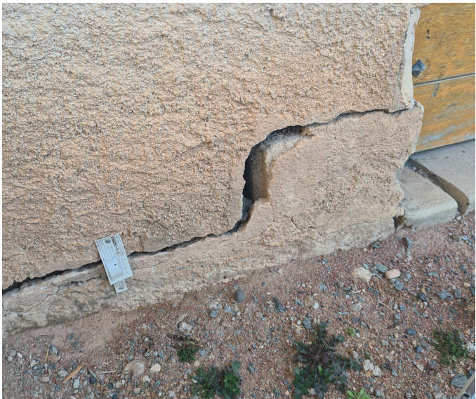
Fig. 33 | Détail sur la fracture en pied de mur.
