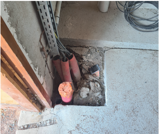
Fig. 34 | Passage de gaines techniques au niveau de la fondation et sortant dans le local : rupture de continuité.
