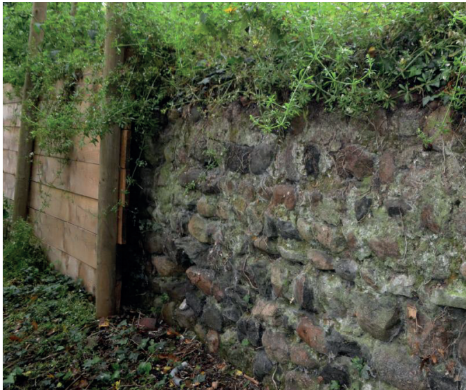
Fig. 12 | Portions de rempart avec étaiments provisoires en bois. ©C.GUYONNET (AP), Repérage des interventions, 2016.
