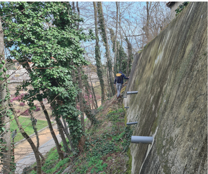
Fig. 27 | Murs de soutènement en béton projeté et barbacanes.
