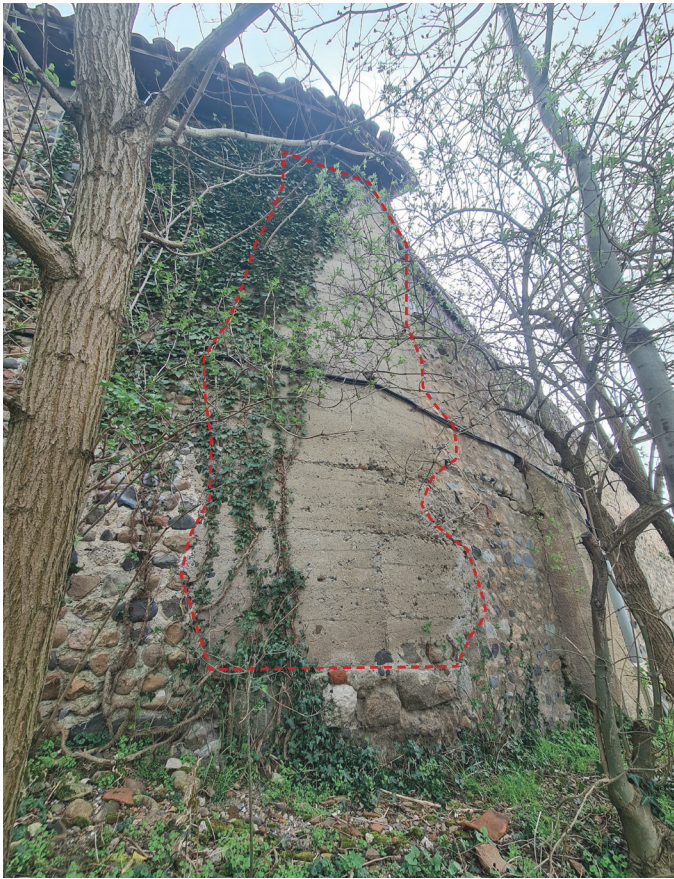
Fig. 44 | Reconstruction de l'angle des communs en béton.
