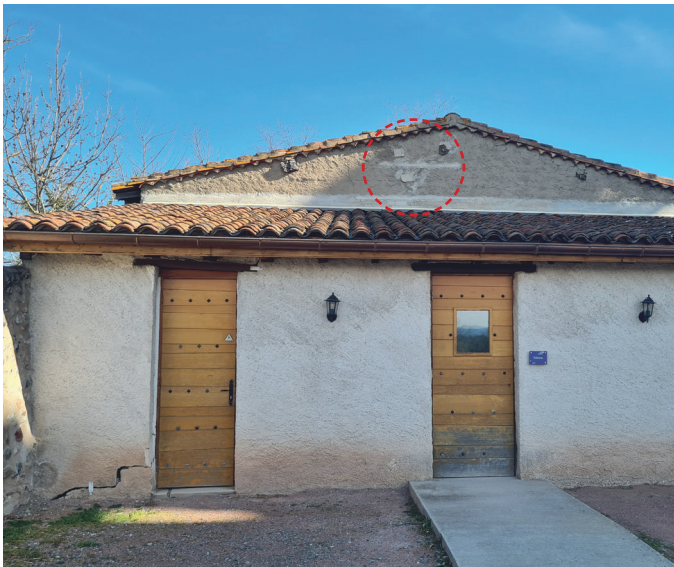
Fig. 35 | Mise en évidence des témoins plâtres sur le pignon ouest des communs.
