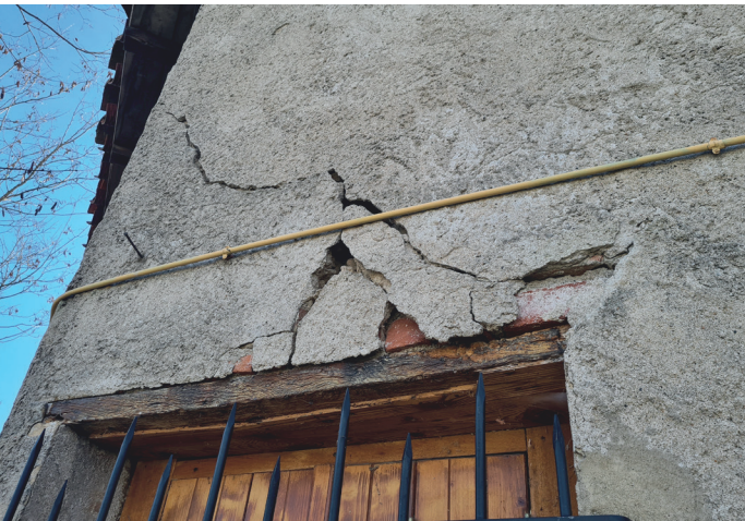
Fig. 40 | Fissurations suivant l'arc de décharge et affaissement du linteau à l'angle nord des communs.
