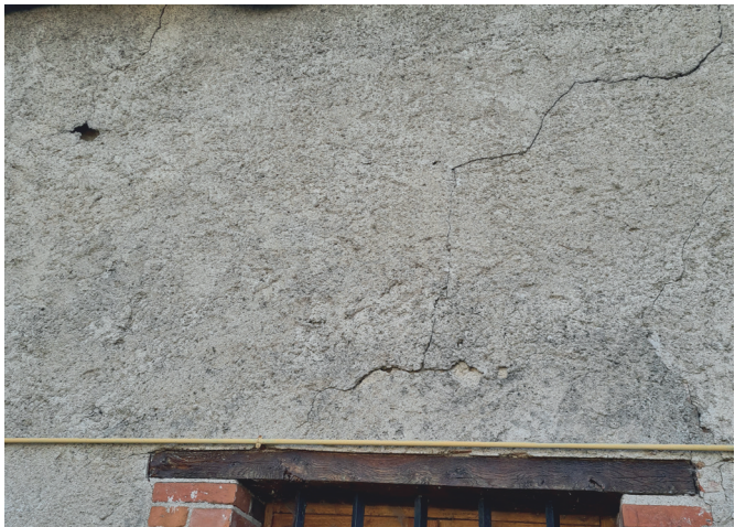
Fig. 41 | Fissuration suivant l'arc de décharge sur la baie ouest.
