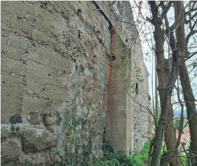
Fig. 43 | Fissure témoignant de l'absence d'harpage du contrefort.
