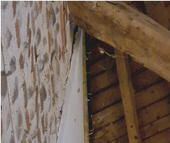
Fig. 37 | Décollement du revêtement plâtre depuis la salle Gallet.
