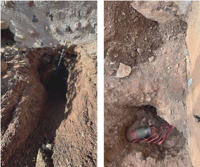
Fig. 50 | Reconnaissances des fondations RF11 et RF3 (mur d'enceinte et locaux des techniques)
