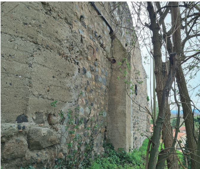
Fig. 26 | Contrefort et reprises en béton le long de l'enceinte nord.
