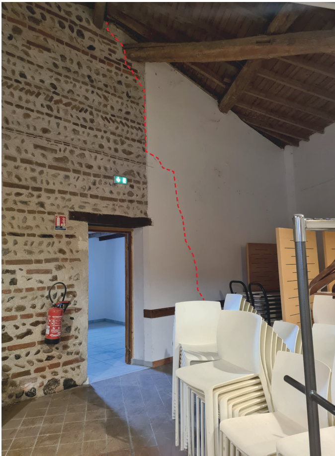
Fig. 36 | Mise en évidence de la fissure verticale sur la paroi ouest. Revêtement plâtre correspondant à la partie reconstruite en béton.
