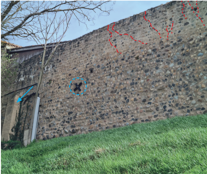
Fig. 42 | Mur d'enceinte nord-ouest avec mise en évidence des fissures en partie supérieure, ancre de tirant et contrefort.
